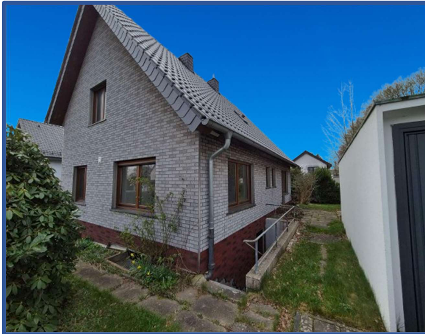
Nord- /Ostansicht Zugang zum Haus über Außenkellertreppe
